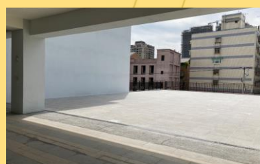
二樓露台，禁止進入
