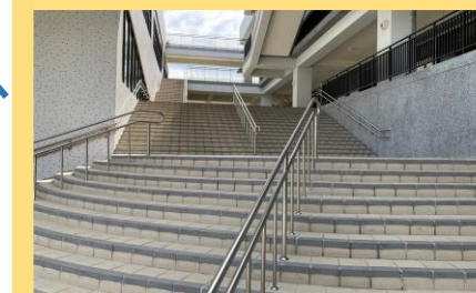
樓梯陡坡，奔跑易發生危險
