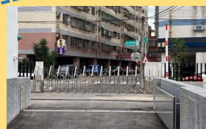
地下車道入口，車輛進出頻繁
